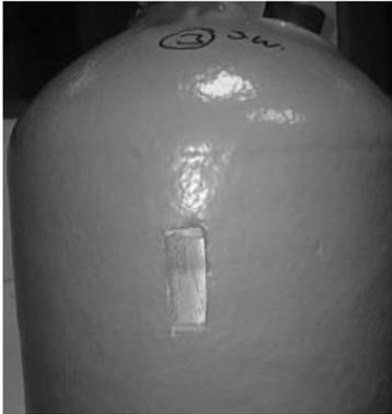
Pulire bene la superficie metallica del serbatoio per stabilire un buon contatto con il Sensore NTC ed inserirlo all'interno dello spazio fino a toccare la superficie in rame.
