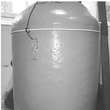
Fissare un cordino per tenere il sensore ben fissato al serbatoio e verificare la temperatura di questo all'interno dell'applicazione della rete Z-Wave (se hai acquistato i prodotti della linea MyVirtuoso Home, si utilizzi l'app MyVirtuoso Home ES).
